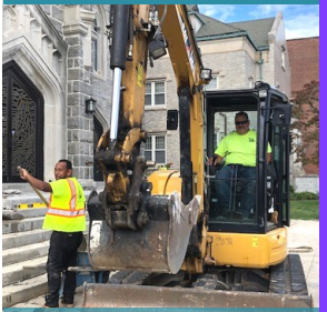
Reparación / escalas de San Pedro
